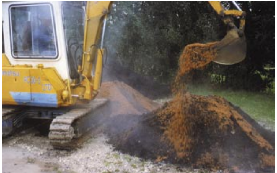
Mit dem Bagger wird eine nährstoffreiche Erdmischung aus Sand und Kies hergestellt - ideal für viele Pflanzen und Ansaaten. Fotos: Witt.
